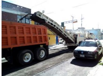
Los trabajos iniciales contemplaron el retiro del pavimento dañado, barrido y limpieza general, para que una vez concluidas las labores de fresado se realice el riego de liga y posteriormente se aplique la mezcla asfáltica, para concluir con las labores de compactación.
